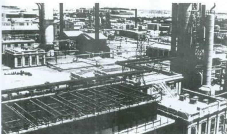
Şəkil 25. Bakı şəhərində neftayırma zavodunun ümumi görünüşü (1937)
